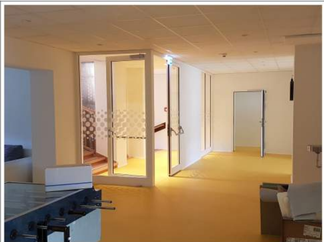
Foyer mit Brandabschnitt zum Stiegenhaus
