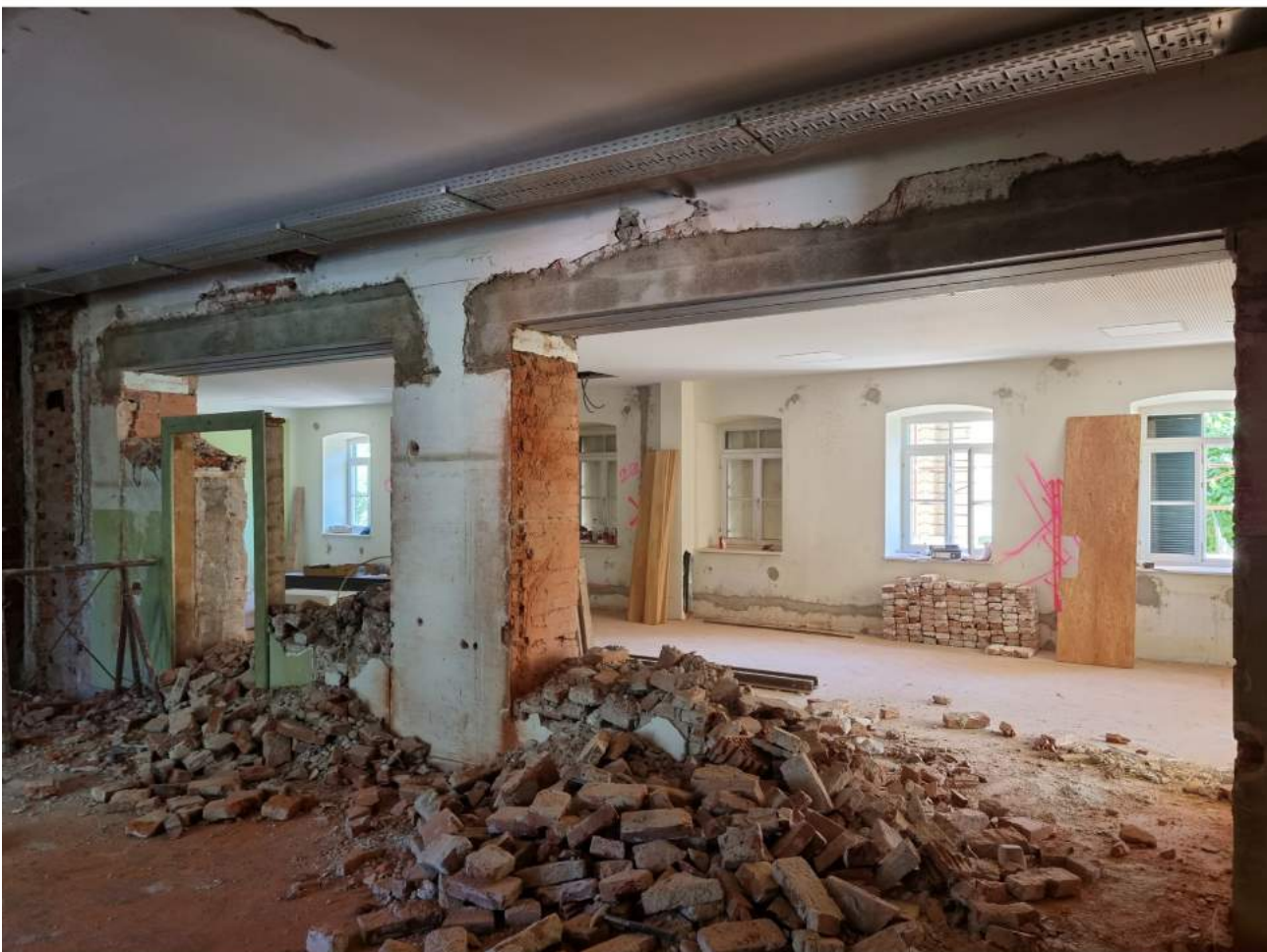
Abbrucharbeiten im Haus
