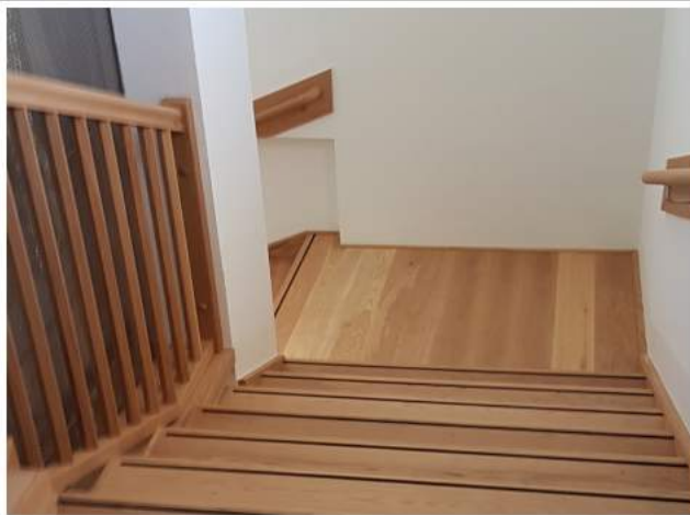
Sanierte Stiege, Lift in der Treppenspindel
