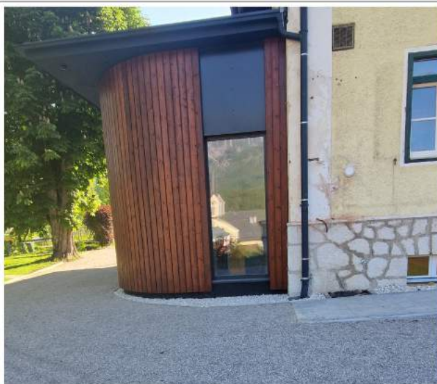
Neu gestalteter Zubau mit Abgang zur Zentralgarderobe
